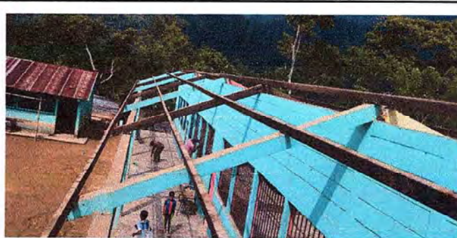
Foto 4: TRABAJO DE ESTRUCTURA
