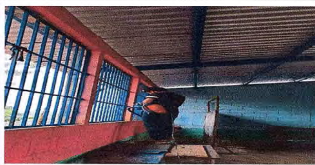
Foto 2: TRABAJO DE MANTENIMIENTO DE BALCONES
