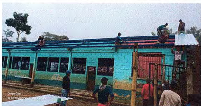
Foto1: TRABAJO DE SUSTITUCION DE LAMINAS A LAMINAS TROQUELADAS
