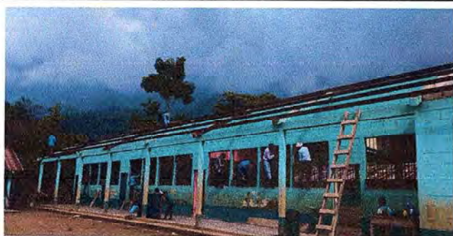
Foto 3: TRABAJO DE MANTENIMIENTO DE MUROS
